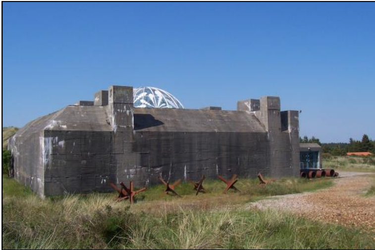
Bunkeren set udefra.
